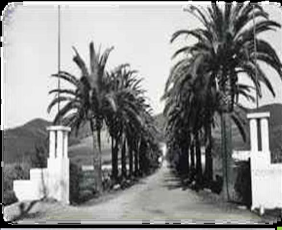
المدخل الرئيسي للمدرسة التطبيقية في الفلاحة و الكروم بفيليبفيل (Philippeville - ALGERIE) ( سكيكدة - الجزائر )
